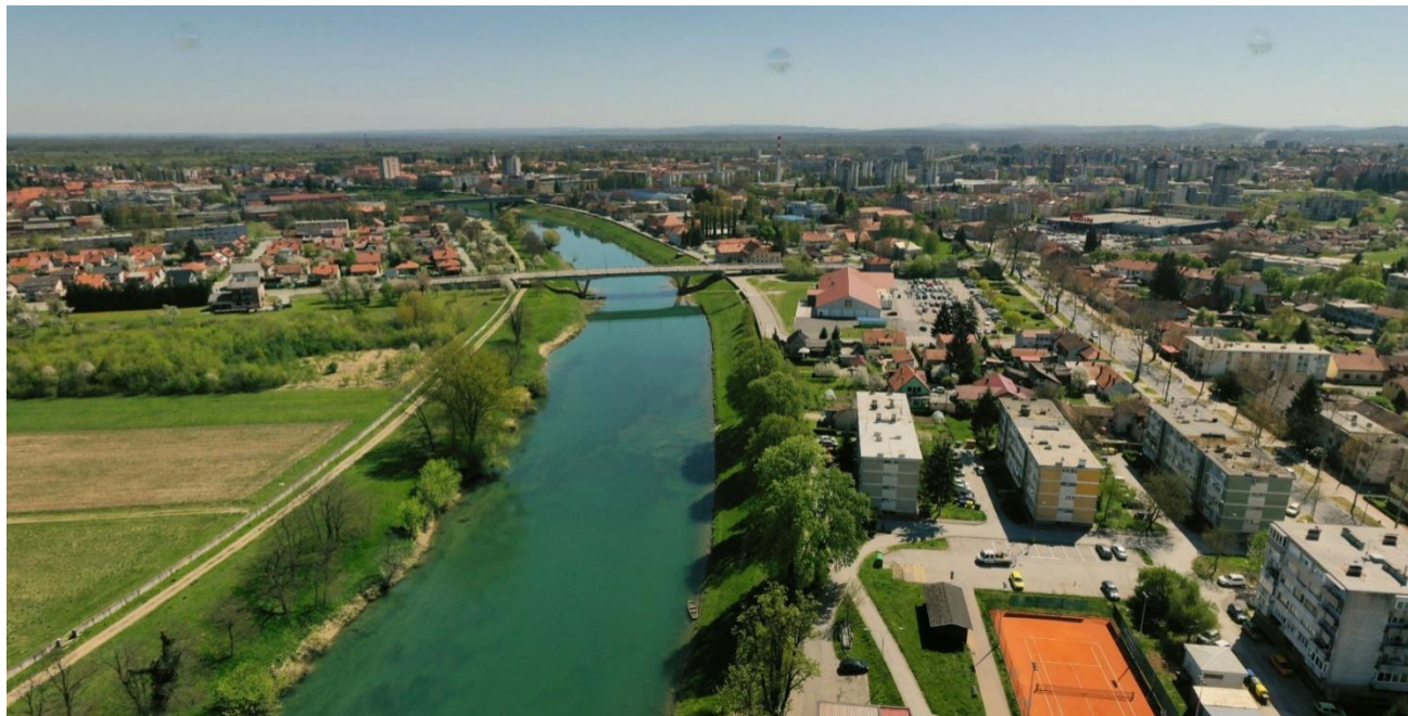
Fotografija 33. Rijeka Kupa u Karlovcu (Izvor: GIS portal Grada Karlovca, 360 panorama)
