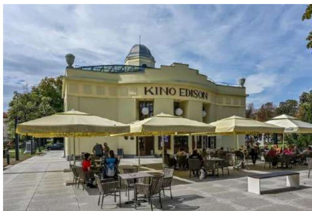
Fotografija 32. Kino Edison nakon obnove
