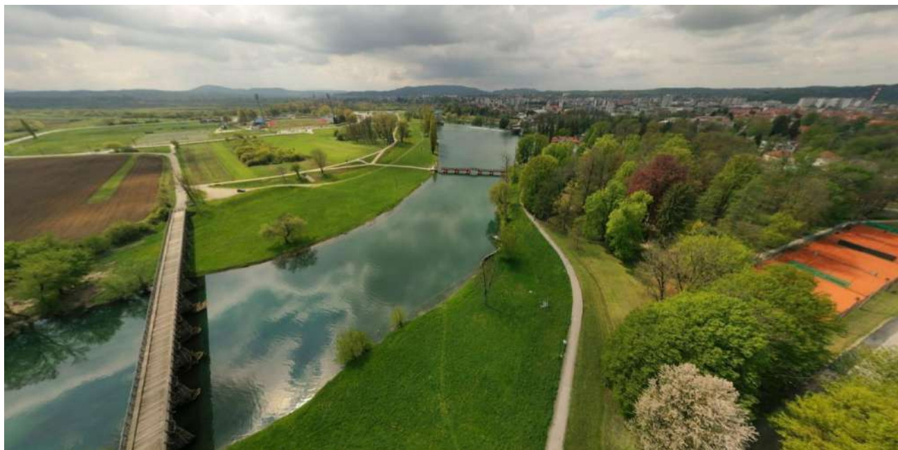
Fotografija 34. Rijeka Korana – pješački i drveni most (Izvor: GIS portal Grada Karlovca, 360 panorama)
